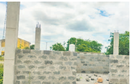
రామాయంపేట: పనులు పూర్తికాక ఉత్సవ విగ్రహాలా ఉన్న నూతనంగా నిర్మించిన భవనాలు
