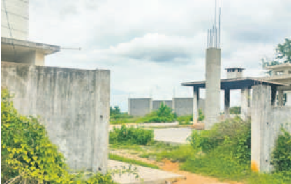
నిర్మాణ దశలోనే ఉన్న రామాయంపేట పట్టణంలోని కాళ్లగడ్డ శ్రీశాన వారికి
