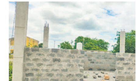
రామాయంపేట: పనులు పూర్తికాక ఉత్సవ విగ్రహాలా ఉన్న నూతనంగా నిర్మించిన భవనాలు
