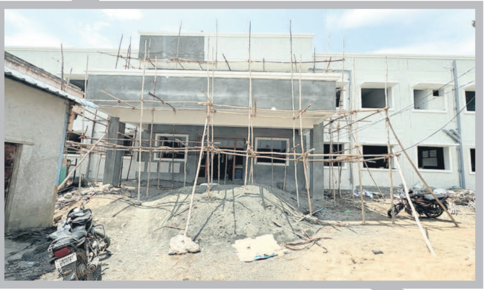
నిర్మాణంలో ఉన్న సిహెచ్ఎస్ నూతన భవనం
