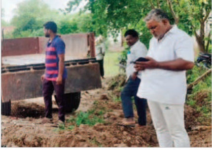
పైపాడులో వాటర్ ట్యాంక్ నిర్మాణ పనులపుతున్న దృశ్యం
