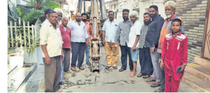
రోడ్డు నిర్మాణ పనులను పర్యవేక్షిస్తున్న బీఆర్ఎస్ నాయకులు
