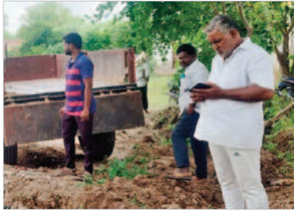
పైపాడులో వాటర్ ట్యాంక్ నిర్మాణ పనులపనుకున్న దృశ్యం
