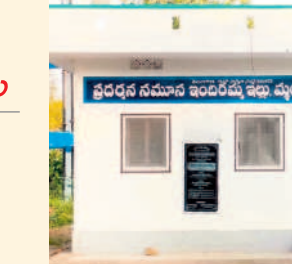
ములుగు ఎంపీడీవో కార్యాలయ అవరణలో నిర్మించిన సమానా ఇంటిరమ్మ ఇల్లు
