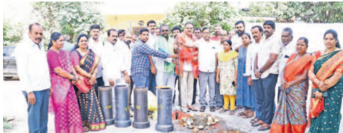
కేవలరెడ్డినగర్లో కార్పొరేటర్ దేవేందరరెడ్డితో కలిసి భూగర్భ డ్రైనేజీ పనులను ప్రారంభిస్తున్న ఎమ్మెల్యే బండారి లక్ష్మారెడ్డి
