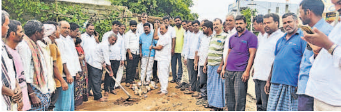
మక్తమాదారంలో అందర్ గ్రాండ్ డ్రైనేజీ నిర్మాణ పనులను ప్రారంభిస్తున్న జీఆర్ఎస్ నాయకులు
