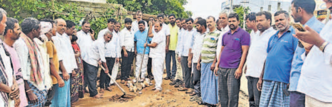
మక్తమాదారంలో అందర్ గ్రాండ్ డైనేజీ నిర్మాణ పనులను ప్రారంభిస్తున్న జీఆర్ఎస్ నాయకులు
