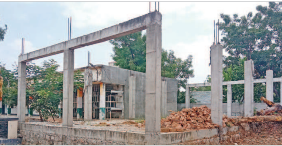
కోడేరు: అసంపూర్ణగా ఉన్నత పాఠశాల డైనింగ్ హాల్ నిర్మాణ పనులు
