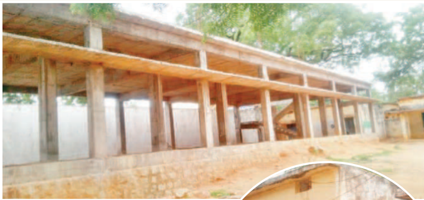
ఉన్నత పాఠశాలలో అసంపూర్ణ నిలిచిపోయిన భవన పనులు
