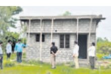
ఇల్లు నిర్మాణ పనులను పరిశీలిస్తున్న ఆడిషనల్ కలెక్టర్
