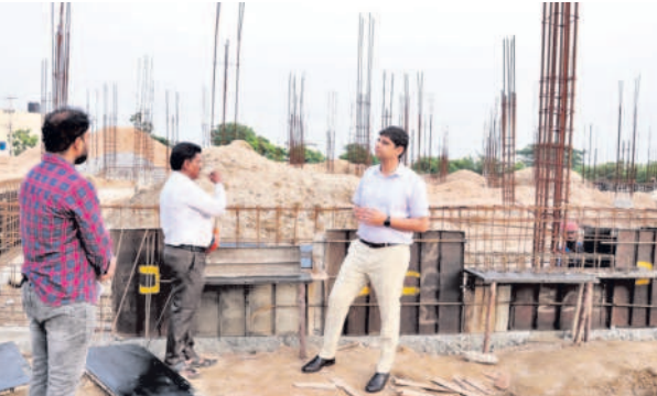
భవన నిర్మాణ పనులను పరిశీలిస్తున్న కలెక్టర్ ఆశీష్ సంగ్వాన్
