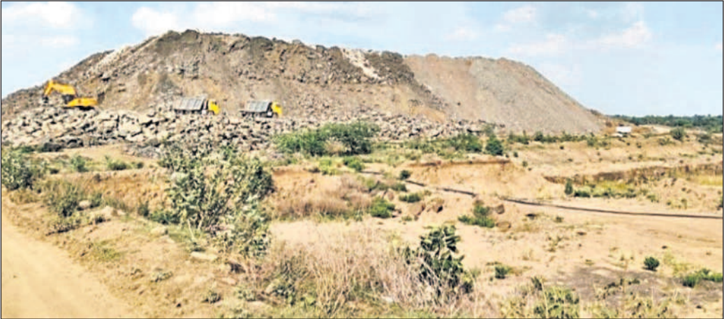
సంగారెడ్డి జిల్లా మనూరు మండలం బోరంప శివారులో నత్తనడకన సాగుతున్న బసవేశ్వర ఎత్తిపోతల పథకం పనులు
