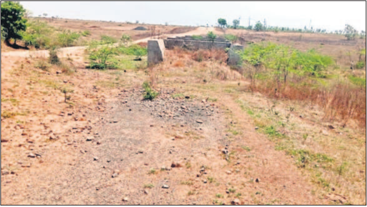
సంగారెడ్డి జిల్లా నాగల్ గిద్ద మండలం మోర్లి అంతర్జాత్య రోడ్డుపై అసంపూర్ణగా నిలిచిపోయిన వంతెన నిర్మాణ పనులు
