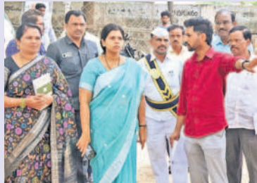
ఎంపీడివో కార్యాలయ ఆవరణలో భవిత కేంద్రం నిర్మాణ పనుల పరిశీలిస్తున్న సర్లగొండ కలెక్టర్ ఇలా శ్రీపాతి
