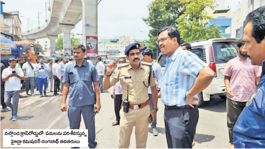
నల్గొండ గ్రాంలో రోడ్డులో పనులను పరిశీలిస్తున్న హైదరాబాద్ కమిషనర్ రంగనాథ్ తదితరులు
