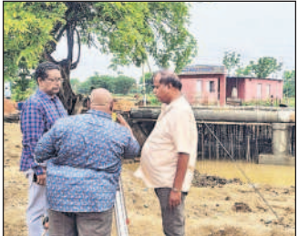
బ్రడ్జి పనులను తనిఖీ చేస్తున్న రాష్ట్ర క్యాబిలీ కంట్రోల్ శాఖ అధికారి మూర్తి
