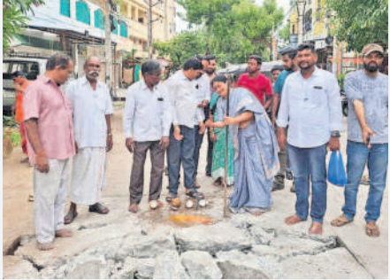
భూలక్ష్మి నగర్ పడ్డ సీస్ రోడ్డు నిర్మాణ పనులకు శంకుస్థాపన చేస్తున్న కార్పొరేటర్ అరణ
