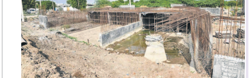
మెదక్-ఎల్మతూర్ రోడ్డు విస్తరణ పనుల్లో భాగంగా సిద్దిపేటలో ఎల్లమ్మగుడికి వెళ్లే దారిలో ఆగిపోయిన బ్రిడ్జి నిర్మాణ పనులు
