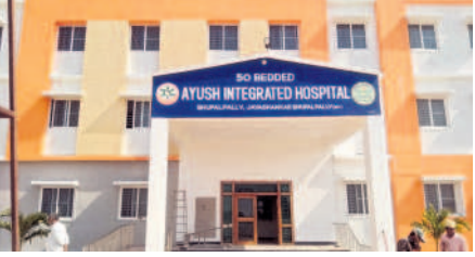
నిర్మాణం కళాశాల ఆధీనంలో ఉన్న ఆసుపత్రి భవనం
