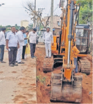
బోయిన్‌చెరువు పనులను పరిశీలిస్తున్న కార్పొరేటర్ నరసింహ యాదవ్
