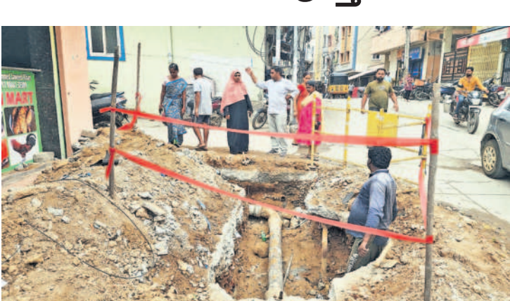
పర్యటనగర్‌లో తాగునీటి పైపులైన్ పనులను పరిశీలిస్తున్న కార్పొరేటర్ సబిహా బేగం
