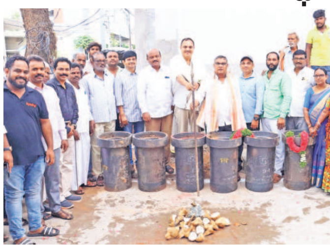
కార్పొరేటర్ ప్రభుదాస్‌తో కలిసి భూగర్భ డ్రైనేజీ నిర్మాణ పనులను ప్రారంభిస్తున్న ఎమ్మెల్యే బండార
