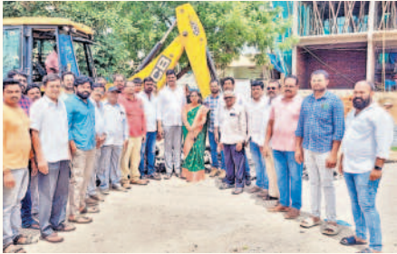
సీసీ రోడ్డు పనులను ప్రారంభించిన కార్పొరేటర్ అభిరెడ్డి
