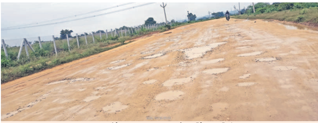
నిర్మాణ దశలోనే నిలిచిపోయిన యాచారం-మీర్ఖాన్ పేట డబుల్ రోడ్డు
