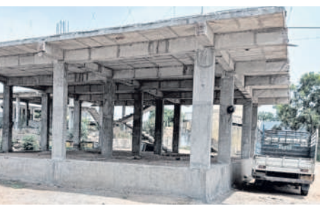
కాలుారీలో అర్థంతరంగా నిలిచిన స్టాన్డీ బ్రాంప్ కార్యాలయం, గోడౌన్ నిర్మాణ పనులు
