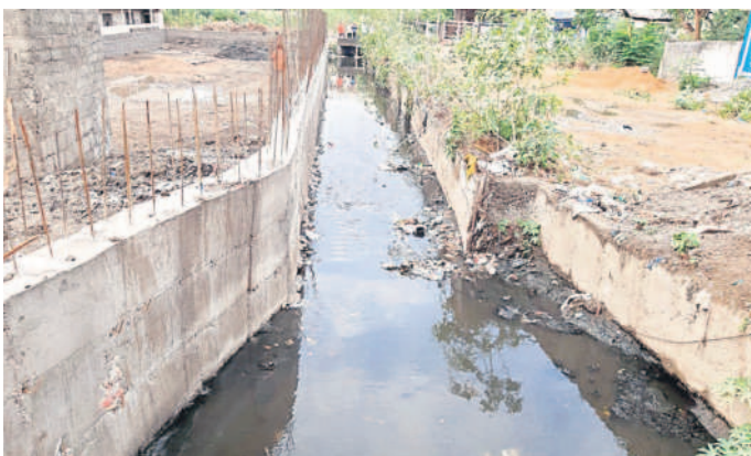
డ్రైనేజీ కాలువపై చేపట్టిన నిర్మాణం
