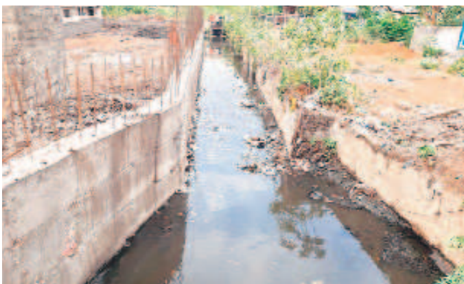
డ్రైనేజీ కాలువపై చేపట్టిన నిర్మాణం
