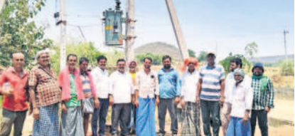
కాపువారిగూడెంలో ఏర్పాటు చేసిన ట్రాన్స్ ఫార్మర్లను ప్రారంభిస్తున్న టైన్ మేన్ మోతీలాల్, గ్రామస్థులు
