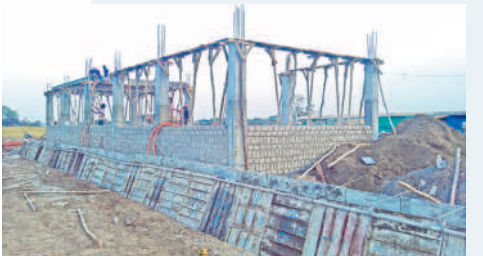
వీడివే హూట్ వద్ద నిర్మాణంలో ఉన్న కల్యాణకట్ట భవనం
