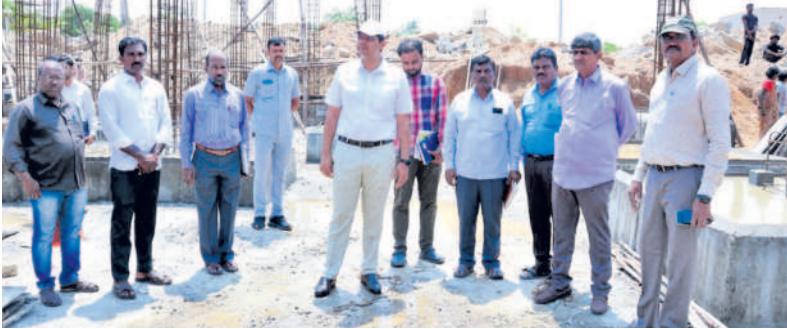
మహిళా శక్తి భవన నిర్మాణ పనులను పరిశీలిస్తున్న కలెక్టర్ అశీష్ సంగ్వాన్
