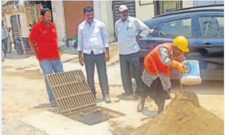
సెంట్రల్ బ్యాంక్ కాలనీలో పూడికతీత పనులను పరిశీలిస్తున్న కార్పొరేటర్ కొప్పుల సరసింహారెడ్డి
