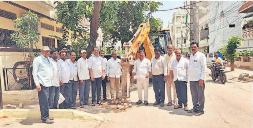
రైల్వే హరిపురి కాలనీలో డ్రైనేజీ పనులకు శంకుస్థాపన చేస్తున్న మూరుకుంట్ల అరవింద్శర్మ తదితరులు
