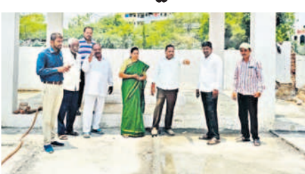
వైకుంఠధామంలో పనులను పరిశీలిస్తున్న కార్పొరేటర్ గీత
