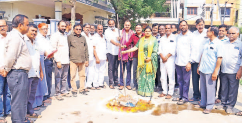
ఏఎస్ రావు నగర్ డివిజన్ కమలానగర్లో సీసీ రోడ్డు పనులకు శంకుస్థాపన చేస్తున్న ఎమ్మెల్యే బండారి లక్ష్మారెడ్డి, కార్పొరేటర్ సింగిరెడ్డి సోమశేఖర్ రెడ్డి
