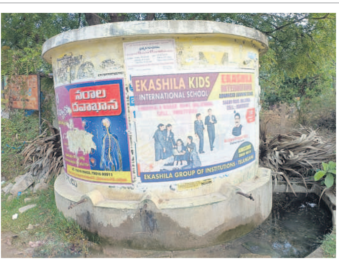
కట్టంగూర్ కత్తెర రోడ్డులో గల మంచినీటి ట్యాంకు చుట్టూ చేదన మురుగు
