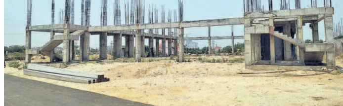
సంగారెడ్డి జిల్లా తెల్లాపూర్‌లో అసంపూర్తిగా ఉన్న సమీకృత మార్కెట్ భవన నిర్మాణం
