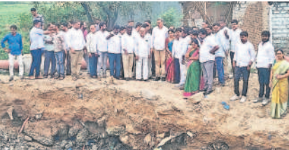
చేర్యాలలో బ్రిడ్జి నిర్మాణ పనులను పరిశీలిస్తున్న జనగామ ఎమ్మెల్యే పల్లా రాజేశ్వరరెడ్డి
