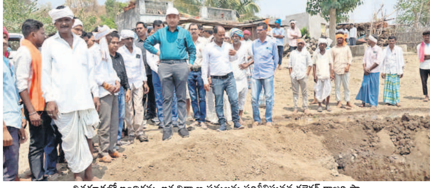
చిత్తగూడలో ఇందిరమ్మ ఇళ్ల నిర్మాణ పనులను పరిశీలిస్తున్న కలెక్టర్ రాజర్షి షా
