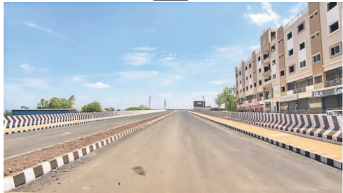
జహీరాబాద్ పట్టణంలోని కల్యాణ సమీపంలోని నిర్మాణ పనులు పూర్తయిన రైల్వే ఫ్లేటవర్ బ్రడ్జి
