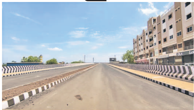
జహీరాబాద్ పట్టణంలోని కంబా సమీపంలోని నిర్మాణ పనులు పూర్తయిన రైల్వే ఫ్లైవర్ బ్రిడ్జి
