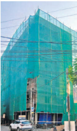
నిజాంపేటలోని సైదప్ప కాలనీ సమీపంలో రెండు ఫ్లాట్లకు కలుపగా తయారవుతున్న అరు అంతస్తుల నిర్మాణం
