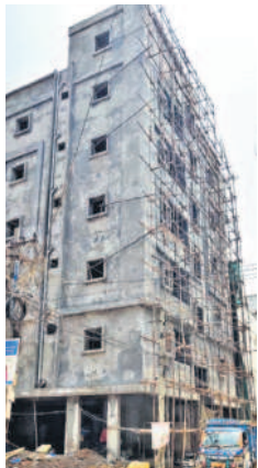
రేణుకాఎల్లమ్మ కాలనీలో రోడ్డునాళ్ల మించి నిర్మిస్తున్న బహుళ లంతస్తులు
