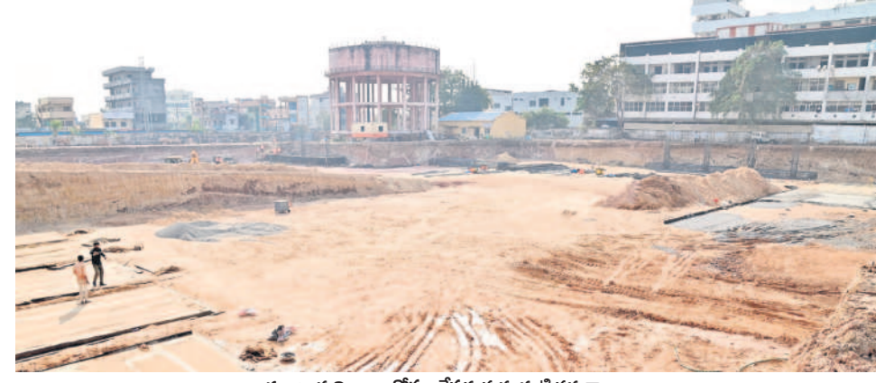
దవాఖాన నిర్మాణం కోసం చేపడుతున్న మట్టి తవ్వకాలు
