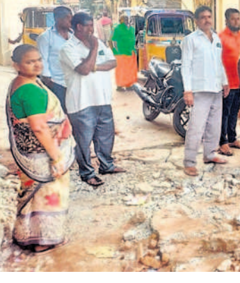
సీసీ రోడ్డు పనులు పరిశీలన
