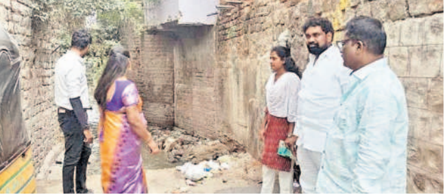
నాలా పనులను పరిశీలిస్తూ కార్పొరేటర్ కంది శైలజ
