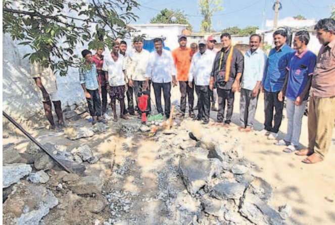
అండర్ గ్రౌండ్ డ్రైనేజీ పనులు ప్రారంభిస్తున్న మున్సిపల్ చైర్మన్ అశోక్
