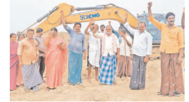
భద్రాద్రి కొత్తగూడెం జిల్లా జూలూరుపాడు మండలంలో సీతారామ ప్రాజెక్టు లింక్ కెనాల్ పనులను అధ్యక్షుడు భూనిర్వాహిత రైతులు
