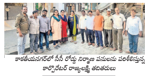
కాకతీయనగర్ లో సీసీ రోడ్డు నిర్మాణ పనులను పరిశీలిస్తున్న కార్పొరేటర్ రాజ్యలక్ష్మి తదితరులు
