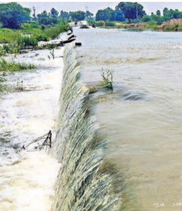
పొట్టిమర్రి రోడ్ డ్యామ్పై నుంచి పారుతున్న కాళేశ్వరం నీళ్లు
